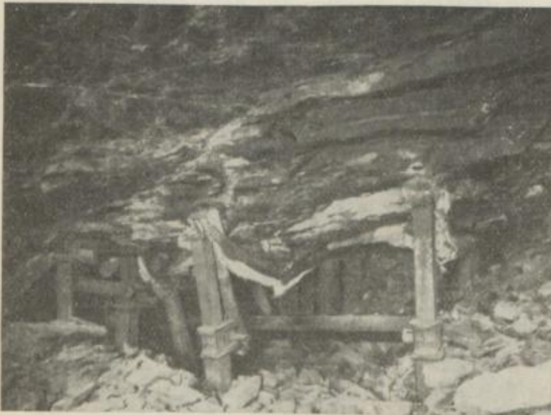
Bild 27. Blick in das Blasversatz-Feld nach dem Gebirgsschlag (nach W. GRÄBSCH)
