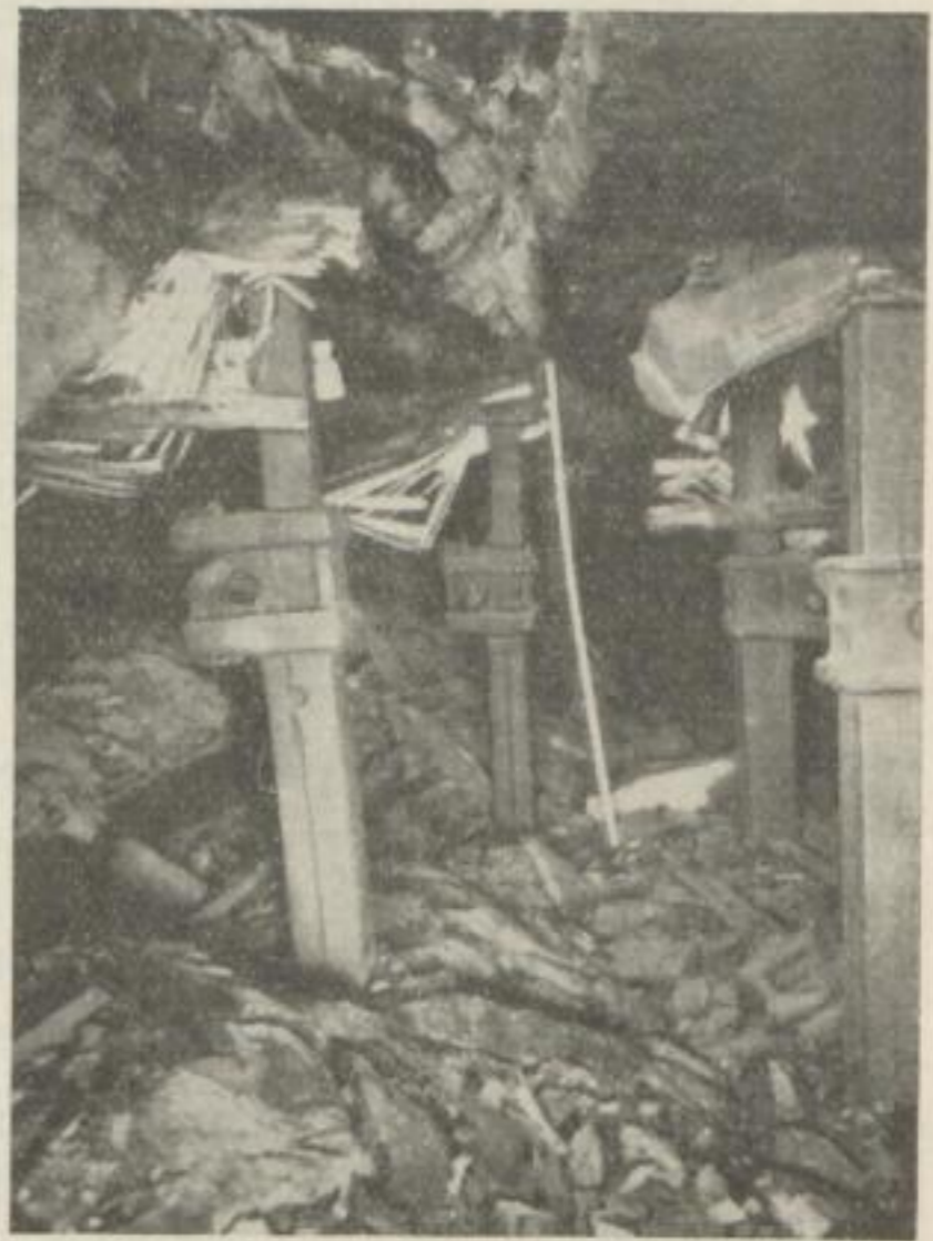
Bild 28. Liegendes und Hangendes nach dem Gebirgsschlag (nach W. GRÄBSCH)
