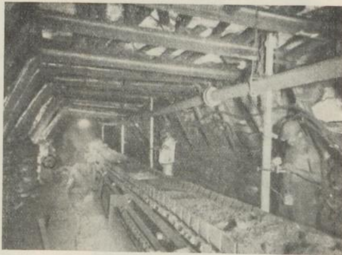
Bild 13. Meßeinrichtung in der Bandstrecke (nach W. GRÄBSCH)
