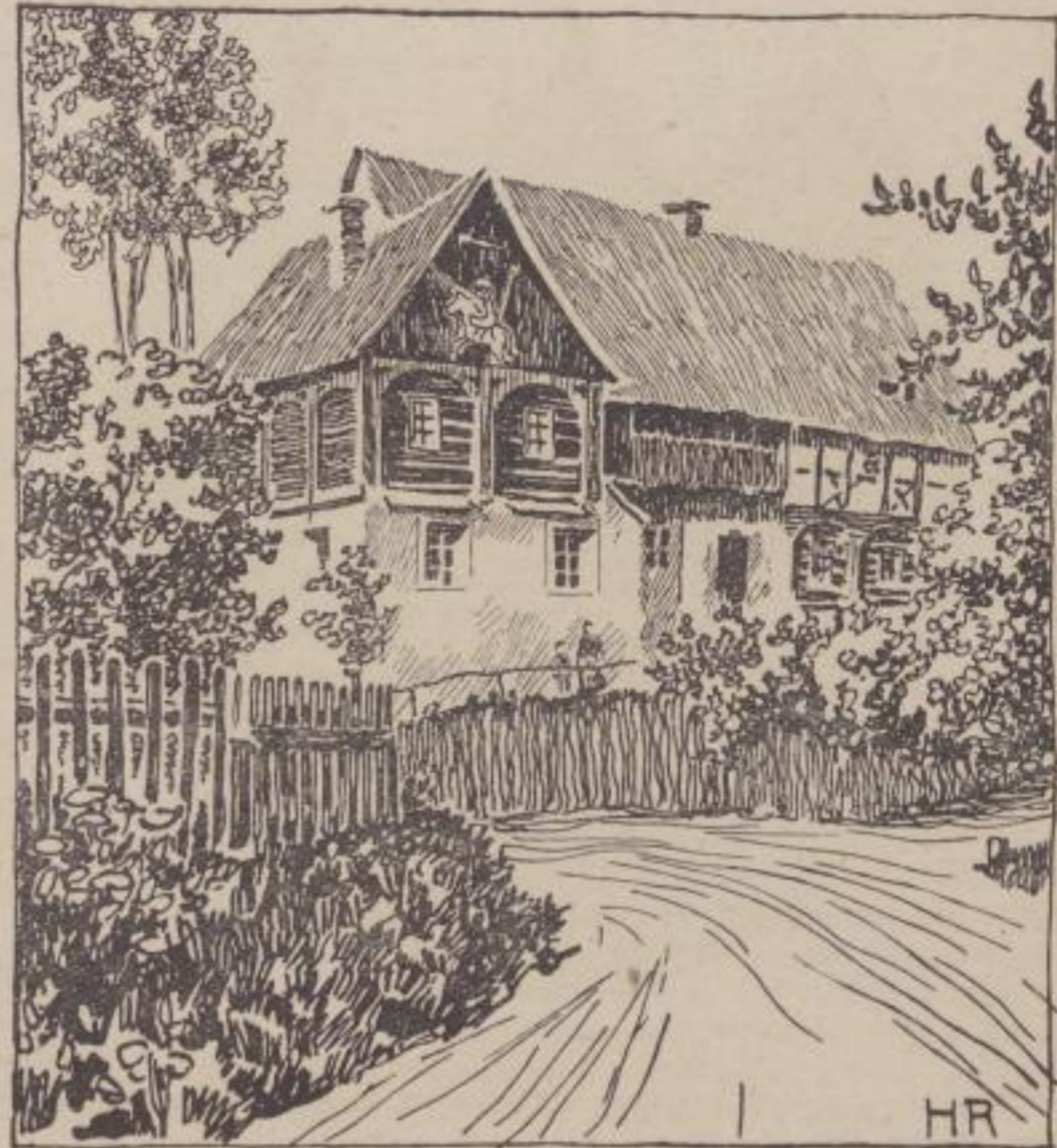
Neusalza-Spremberg, Blockwerk im Obergeschoß.
