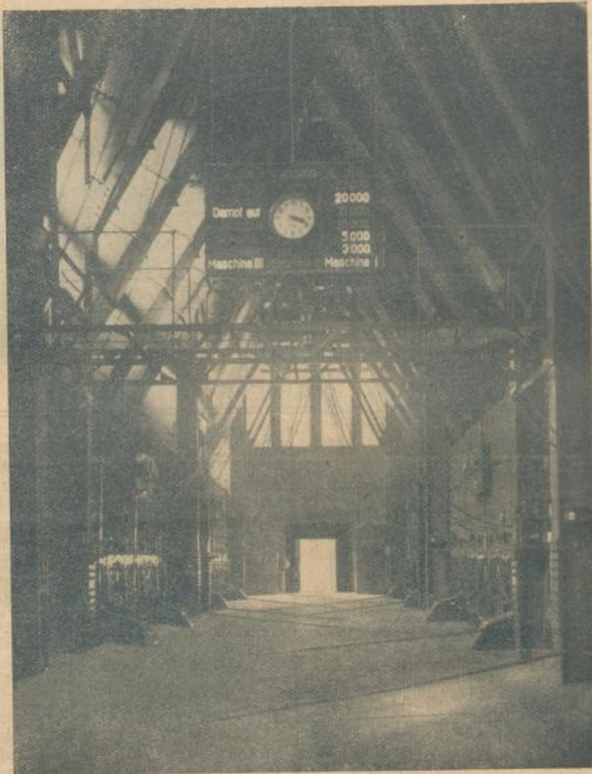
Kesselhaus im Kraftwerk 2
