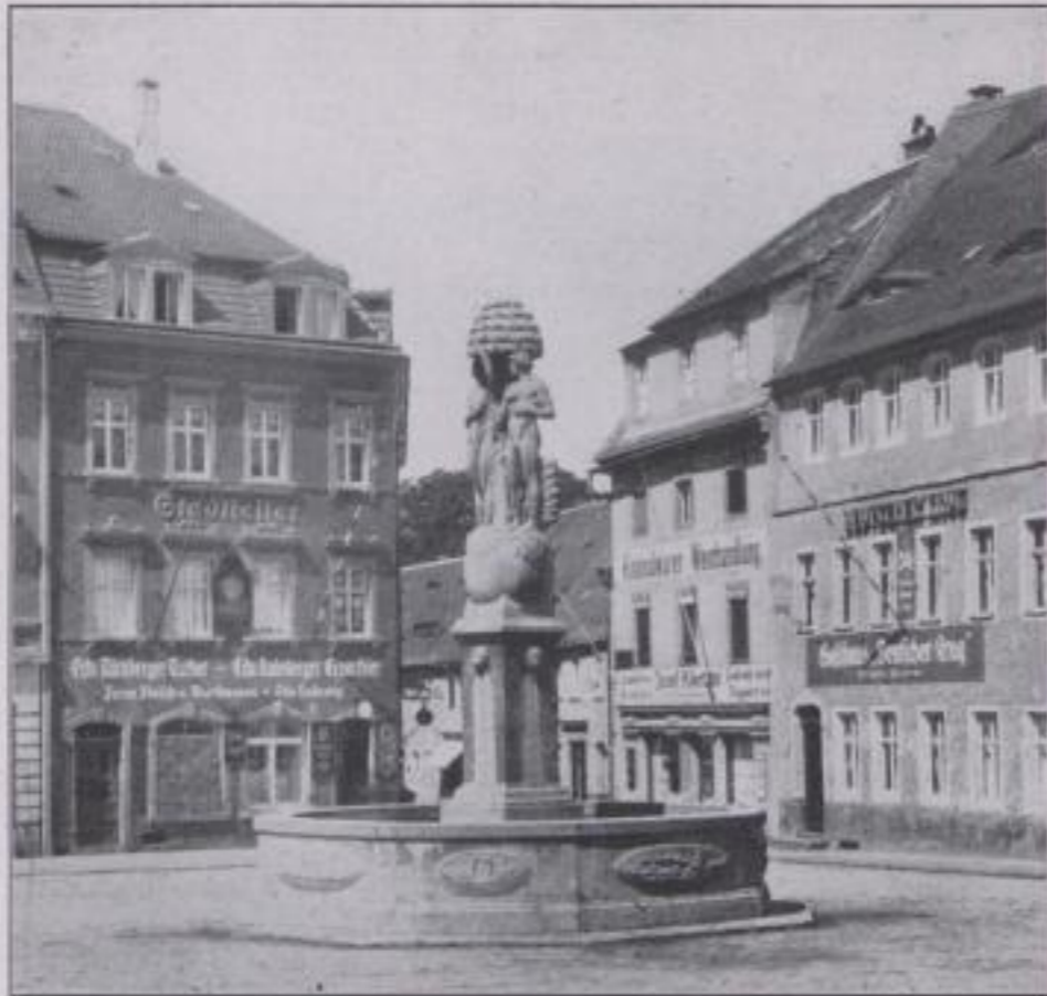
Nordwestecke des Marktes mit dem Zierbrunnen
