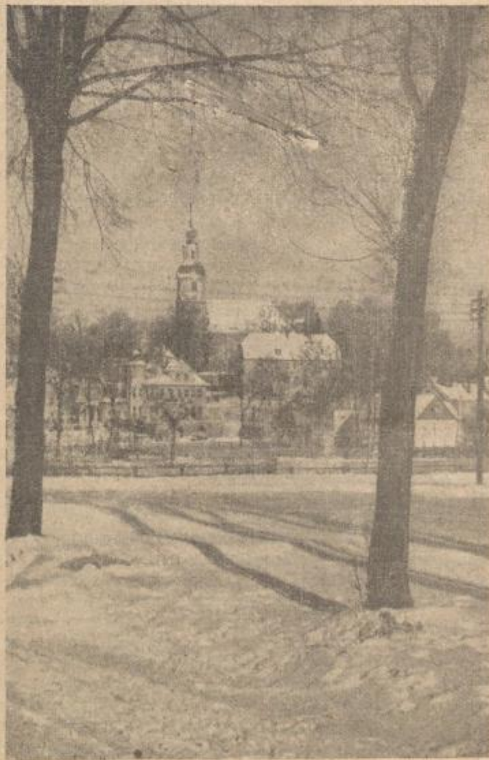
Großröhrsdorf i. Sa. — Partie an der Kirche
