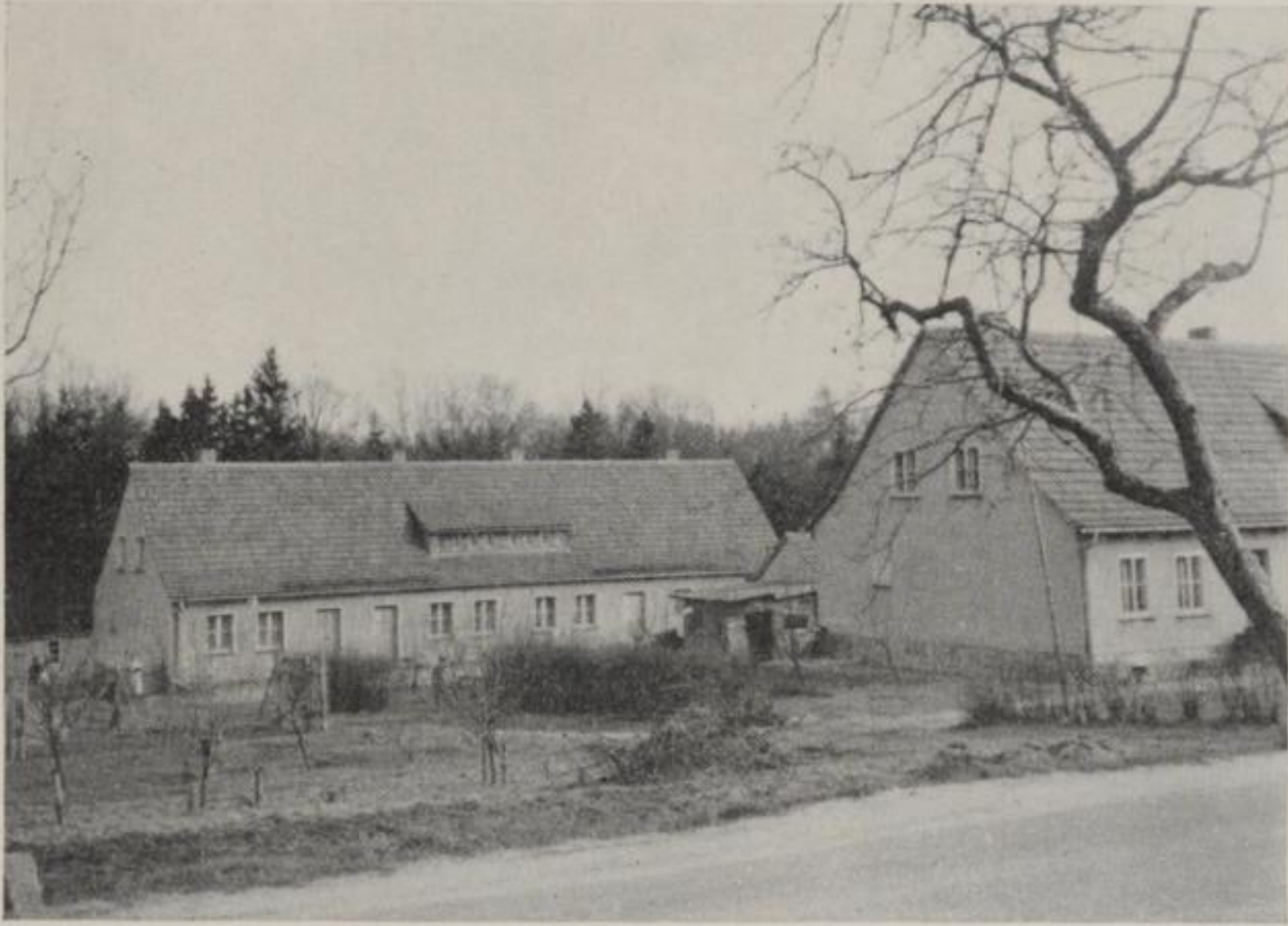
Abb. XII Neue Landarbeiterwohnungen in Kunnerwitz
