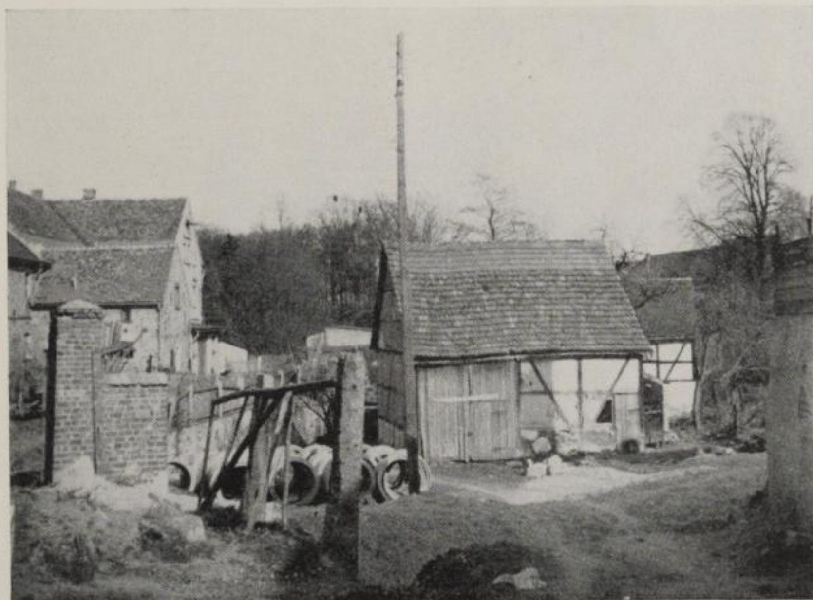
Abb. IX Ehem. Landarbeiterhäuser in Kunnerwitz
