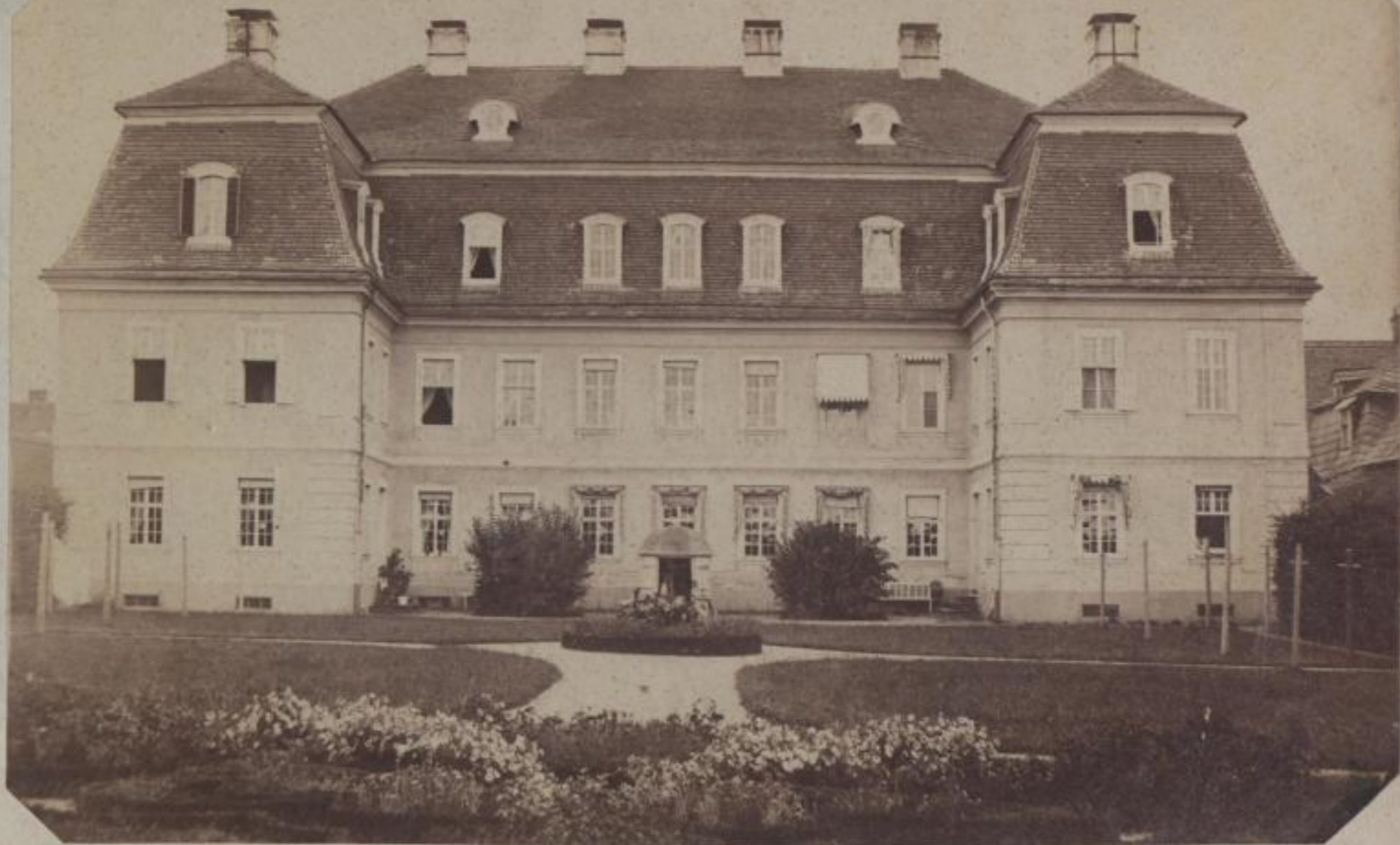
Das Heringskuchenhause in Lüneburg von der Gustavstraße.
