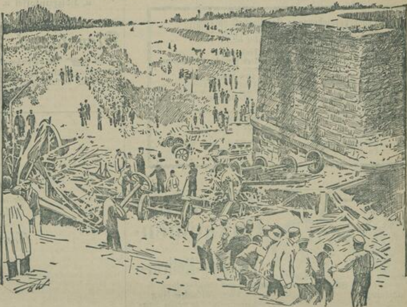
Das Eisenbahn-Unglück bei Bilbao-Saragozza in Spanien geschah dadurch, daß die Eisenbahnbrücke bei Montalvo nachgab, als der Expresszug darüber fuhr. Die beiden Lokomotiven mit
