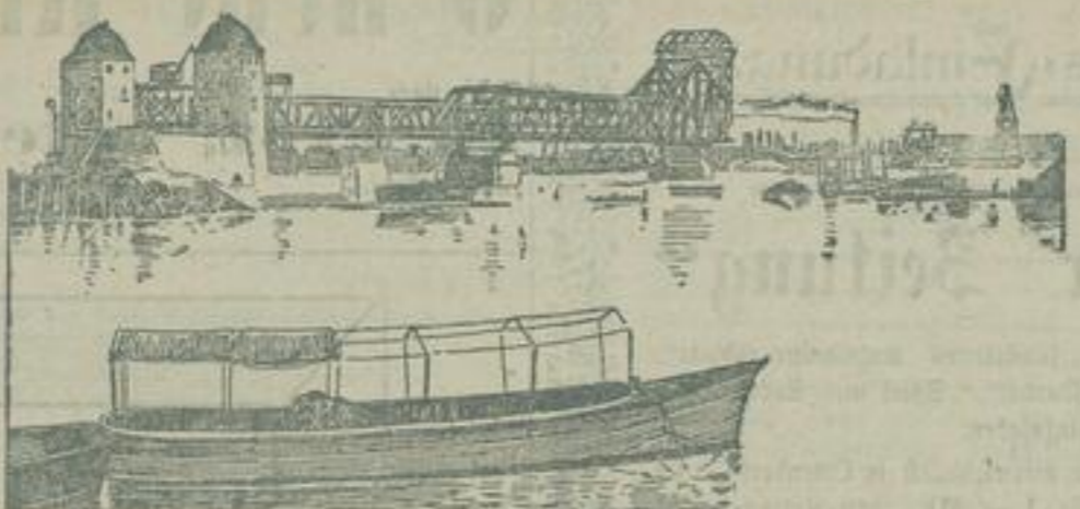
Die neue große Rheinbrücke zwischen Ruhrort und Homburg geht allmählich ihrer Bauvollendung entgegen. Aus dem Bildwerk, den man für die Brückenanlage ausgegraben hat, gingen die Ver-
