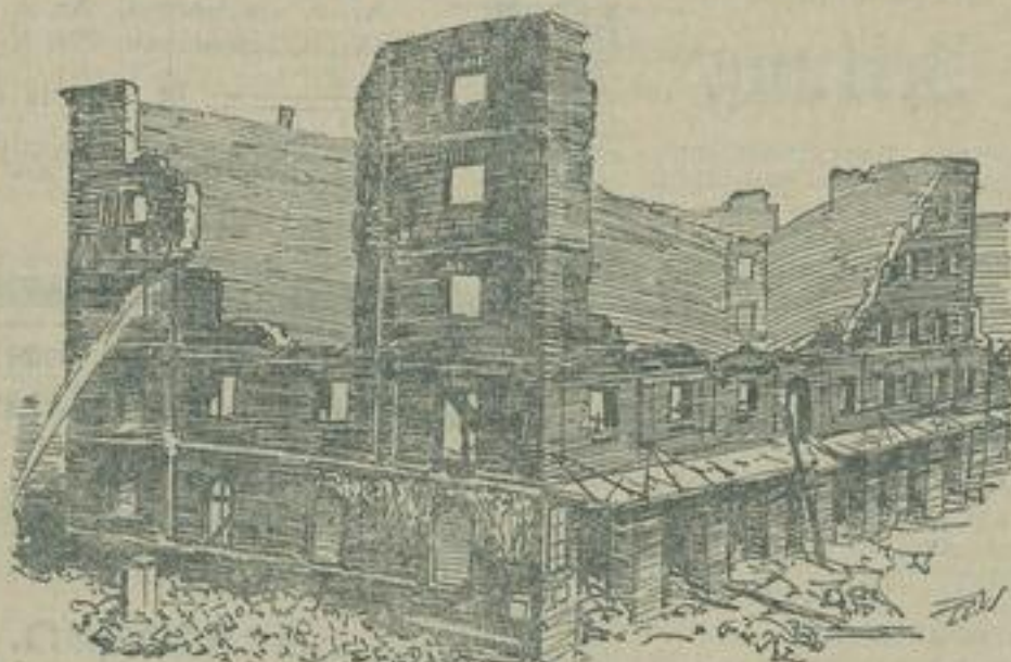
Der Viktoria-Speicher in der Köpenicker Straße zu Berlin ist zum großen Teil ein Haub der Flammen geworden. Nur der äußersten Anstrichung der Feuerwehr, die über 24 Stunden arbeitete, ist es zu danken, daß kein weiteres Unglück verhängt worden ist, das zweifellos entstanden wäre, wenn die großen Mengen Spiritus, die in den Kellerkammern des Speichers lagerten, zur Explosion gekommen wären. Selber fand ein Arbeiter den Tod in den Flammen.
