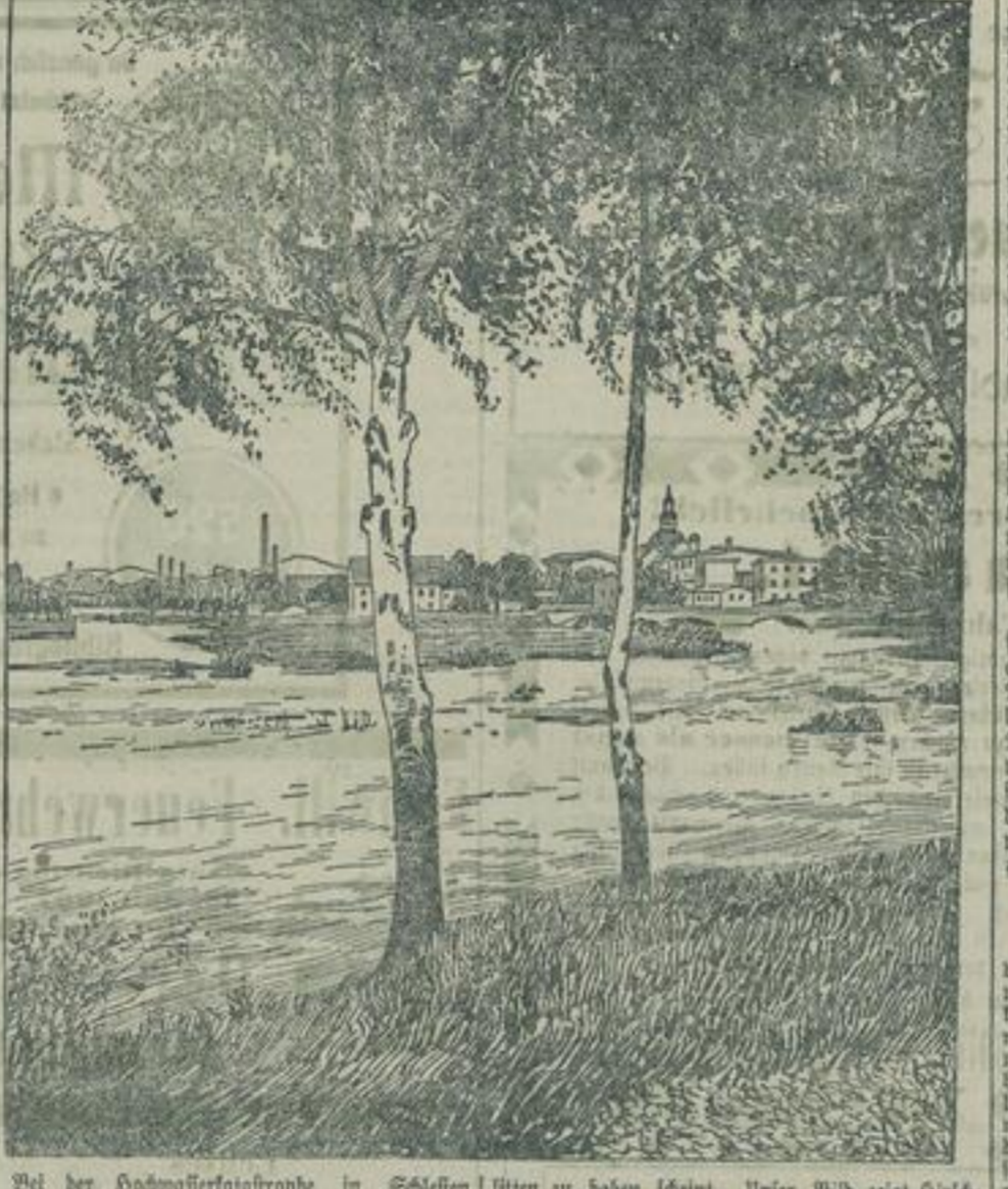
Bei der Hochwasserkatastrophe in Schlesien konzentrierte sich das Dampfinteresse auf Hirschberg, da dieser Ort und seine Umgebung am meisten gelitten zu haben scheint. Unser Bild zeigt Hirschberg während der Überschwemmung vom Krankenhaus aus. Rechts ist die Stadtkirche zu sehen.
