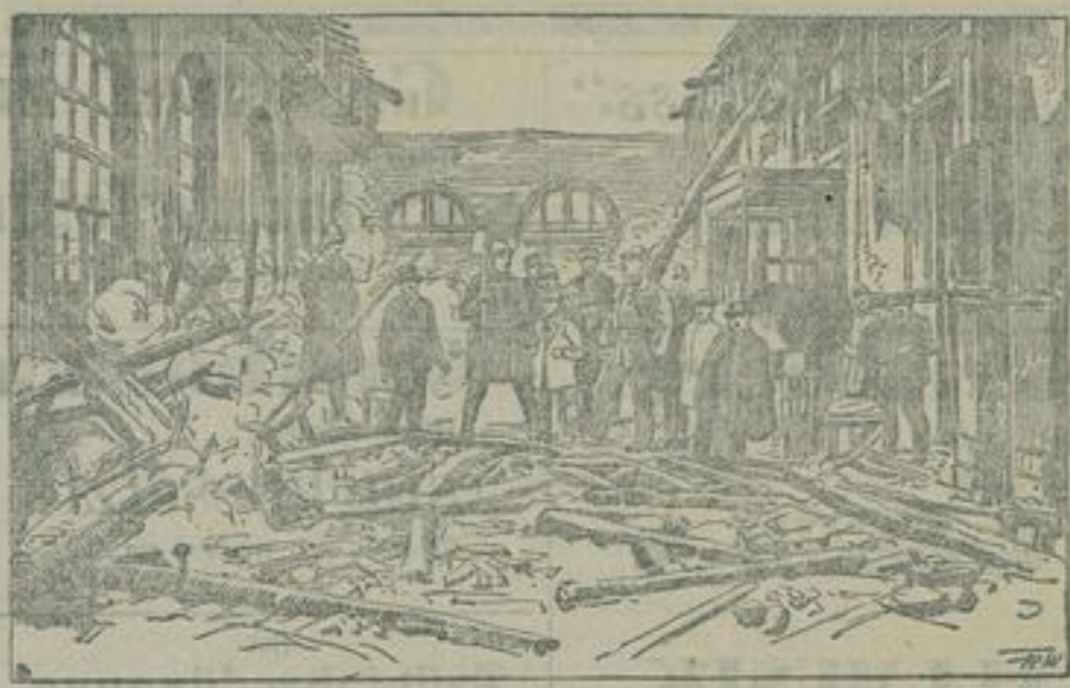
Ein verheerender Brand hat kürzlich in Genf den in französischem Besitz befindlichen großen Bahnhofsbahnhof auf dem Weg Canada eingestürzt. Das Feuer, das durch das Überheizen eines Ofens entstanden ist, hat das Bahnhofsgebäude und das Bahnhofsgebäude zerstört. Die Bahnhofsgebäude sind zerstört. Die Bahnhofsgebäude sind zerstört. Die Bahnhofsgebäude sind zerstört.
