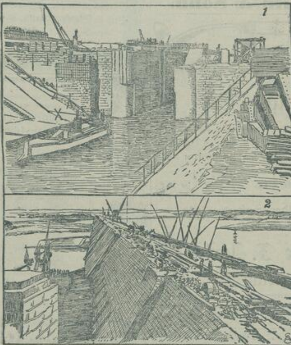
1) Die Erweiterungsarbeiten. 2) Gesamtansicht des Dammes.
