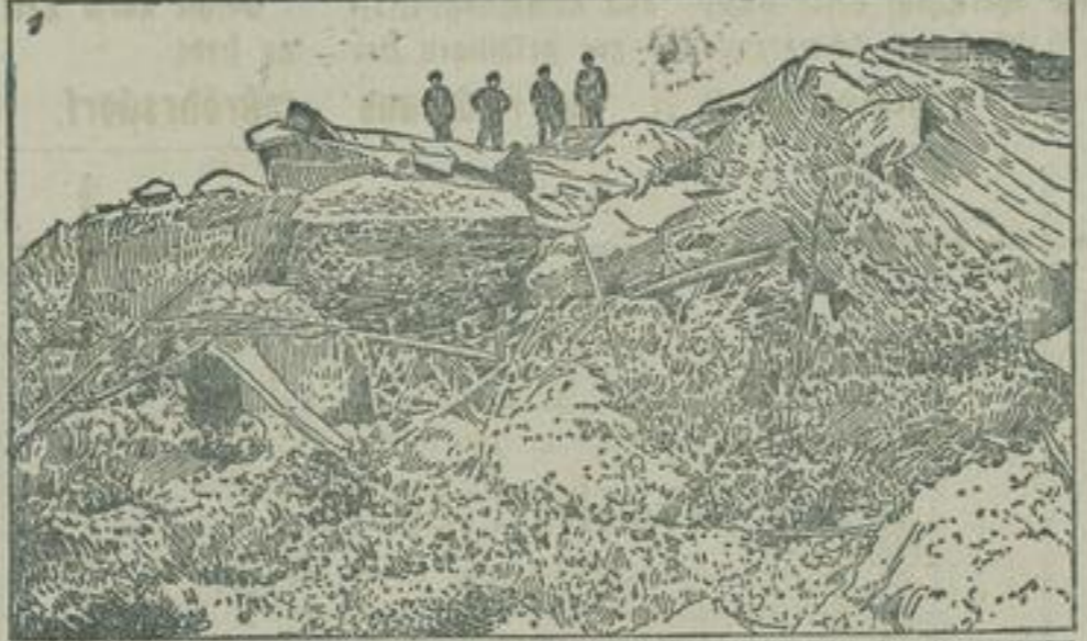
1. Zerstückte Eisenbetondecke am Fort 11. 2. Ansicht eines zerstörten Fortens nach der Beschussung.
