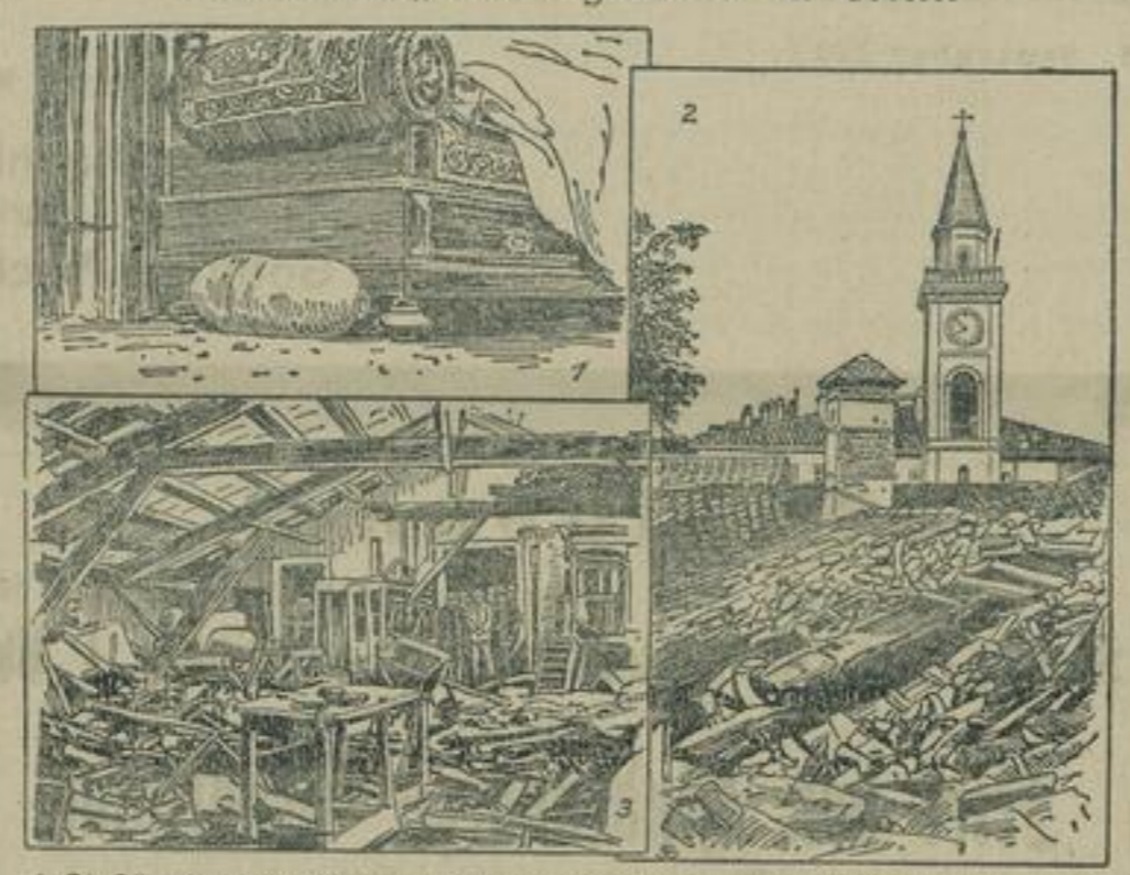
1. Die Fliegerbombe durchschlagt zwei Stockwerke und drückt dann, ohne zu explodieren, neben einem Divan liegen. 2. Soldat einer italienischen Fliegerbombe im Triester Viktorpalast. 3. Durch eine Fliegerbombe hervorgerufene Zerstörungen auf dem Dachboden des Hauses.
