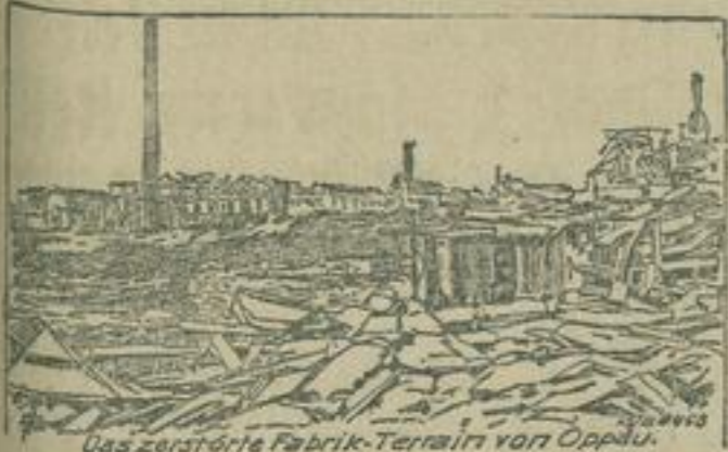
Das zerstörte Fabrik-Terrain von Oppau.
