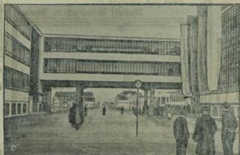
Kandinsky, Paul Klee u. a. erschienen. — Unter Bild zeigt den Refekt, vor dem mit Fahnen geschmückten neuen Bauhaus in Dessau, in der Mitte die Brücke, die die beiden Teile des neuen Bauhauses miteinander verbindet.
