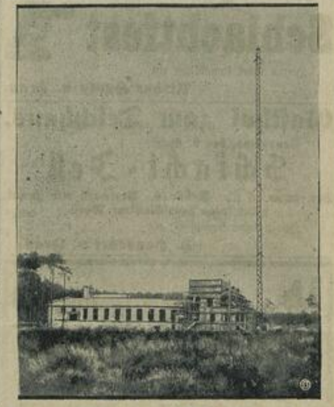
Der größte europäische Rundfunksender im Bau.
