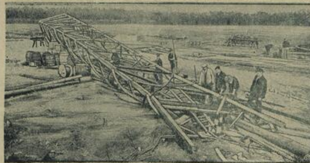
Unter Bild zeigt den umgestürzten Turm des Groß-Rundfunksenders Jelen.
