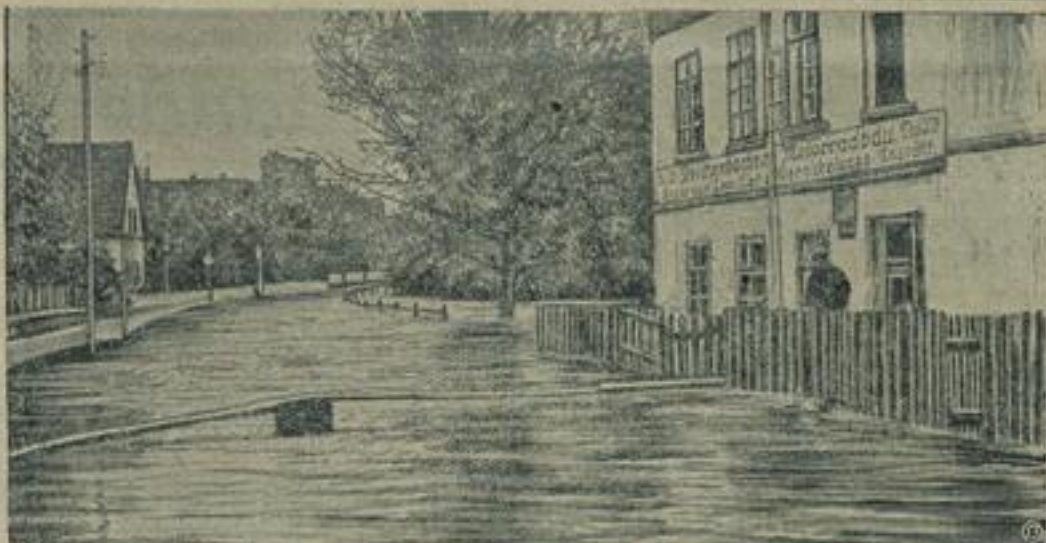
Hochwasser in Schlesien.
