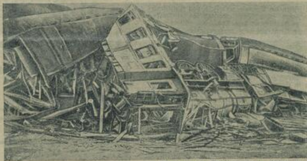
Erste Aufnahme des zerstörten Zuges.
