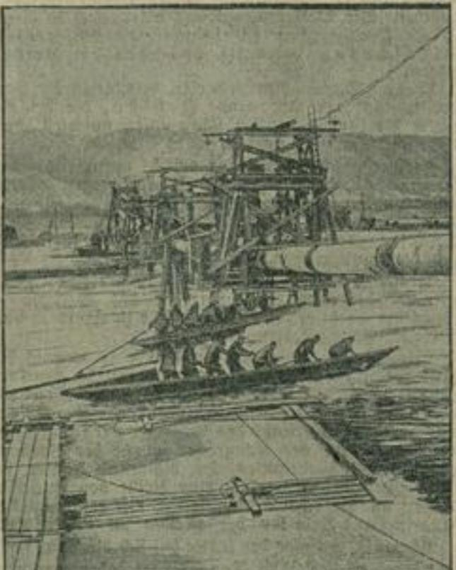
In der Nacht zum Montag wurden die Dächerrohre, die das Wasserwerk bei Niederponitz mit dem linken Elbufer der Stadt Dresden verbinden, in die Elbe eingegossen. Der Vorgang hatte trotz der scharfen Räte laufende Zuschauer angelockt, die das romantische nächtliche Bild mit seinen technischen Einzelheiten aufmerksam beobachteten. — Unser Bild zeigt das schwierige Werk. Der Kampf gegen das Treibeis, welches das ganze Werk in Gefahr bringen und zur zeitweiligen Einstellung der Arbeit zwingen konnte.
