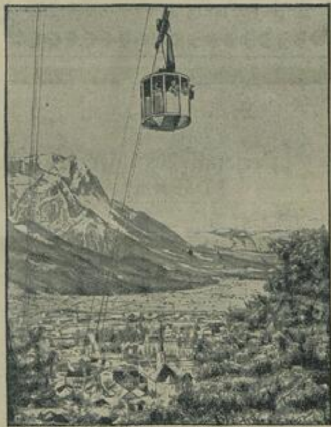
Die neue Seilsehwebbahn bei Garmisch-Partenkirchen.
