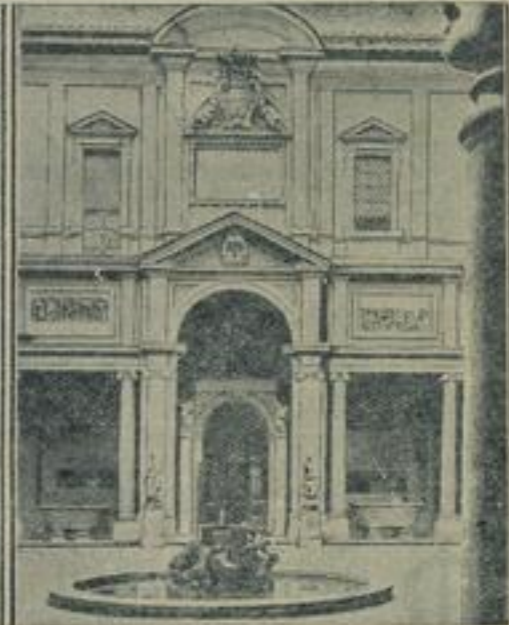
vatikanischen Bibliothek ereignete sich ein schwerer Einsturz. Die Marmorplatten durchschlugen drei Stodwerke und begruben mehrere Menschen, die in dem Raum gearbeitet hatten, unter sich. Fünf Menschenleben, darunter ein junger Direktor der Bibliothek, waren die Opfer der Katastrophe.
