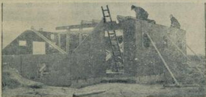
Stahlfabrik für Erwerblosen-Zielanlagen können in 10 Tagen errichtet werden. Oben: Ein Stahlhaus kurz vor seiner Fertigstellung. Unten: Die Montage der Außenwände.
