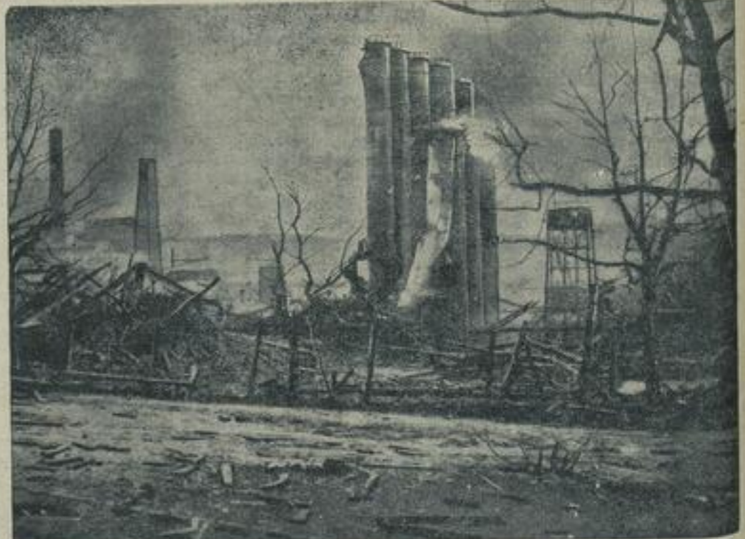
Blick auf die vernichteten Werkanlagen: An vielen Stellen schlugen noch die Flammen aus den Trümmern.
