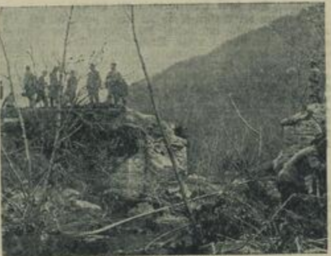
Gesprengte Grenzbrücke - Auf ihrem Rückzug haben die Griechen auch diese Brücke gesprengt. Es wird aber kaum lange gedauert haben, bis durch unsere Pioniere eine neue feste Brücke gebaut wurde.
