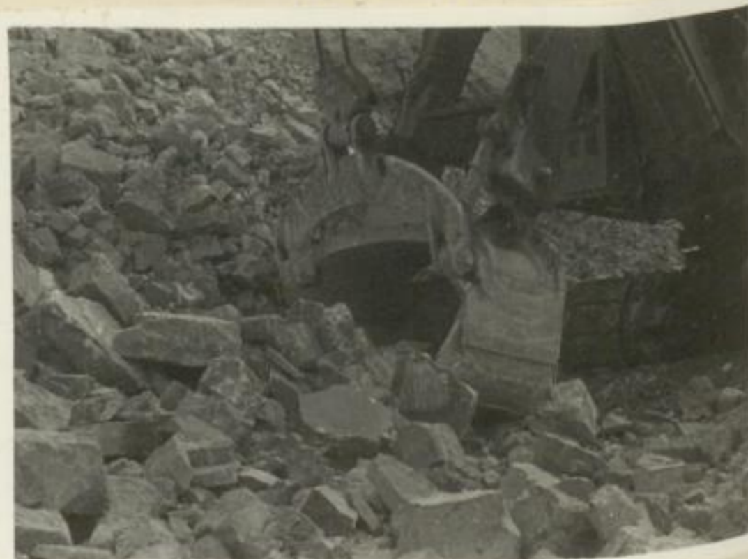
Abb.123-126: Baggerfähiges Haufwerk bei einer Großbohrlochsprengung mit ms-Zündung.
