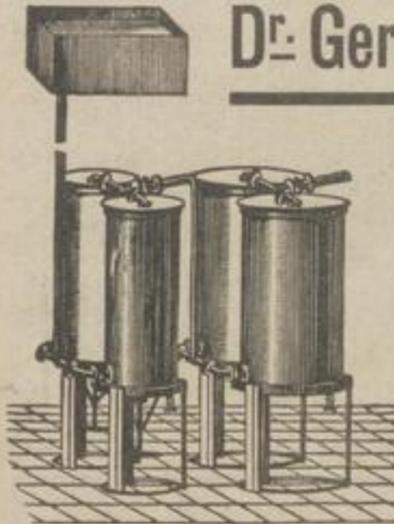
Billigstes und rationellstes Verfahren zur Gewinnung von tadellosem **Nutz- und Trinkwasser** in grossem Maassstabe. Specielles Verfahren zur Reinigung von **Kesselspeisewasser**. Ueber 100 grosse Anlagen in Betrieb.
