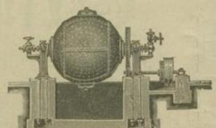
Turbinenrohre, Hadern- und Strohkocher, Behälter, Seifenkessel Patent Schumann
