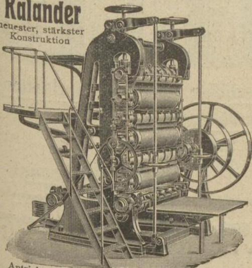
Antrieb mit zwei Geschwindigkeiten ohne Zahnräder
