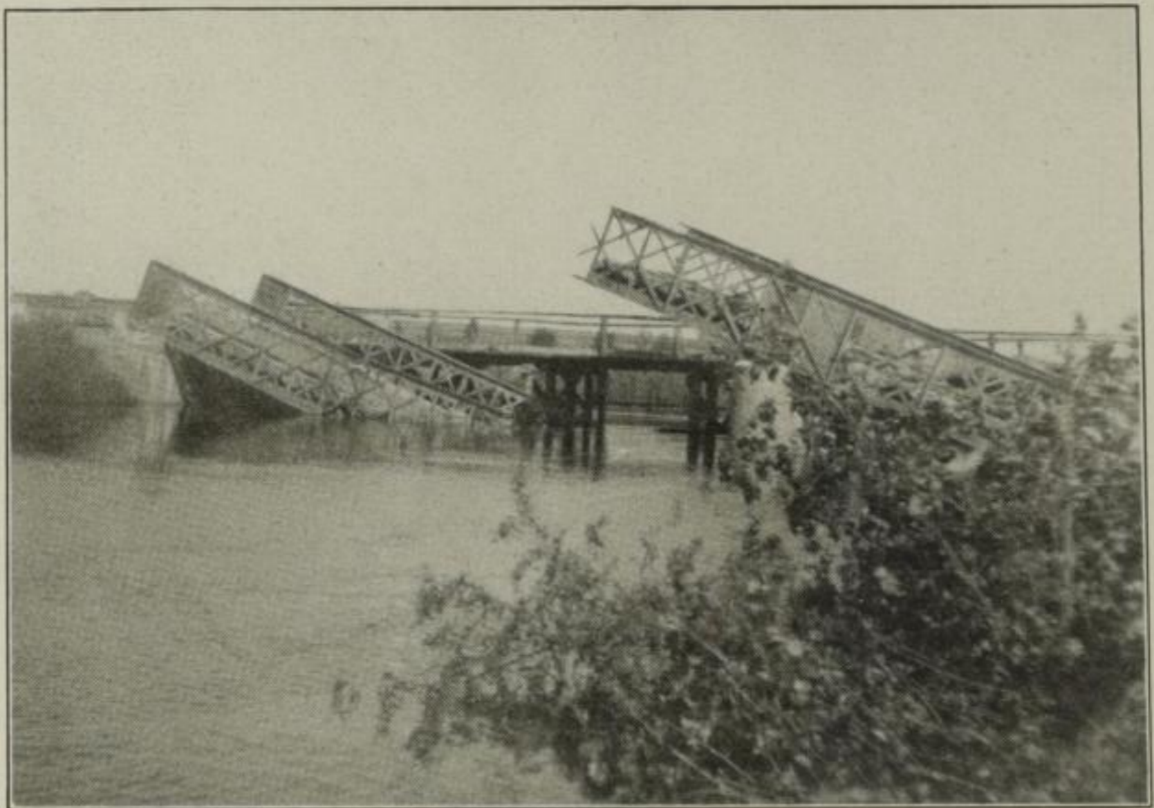
Zerstörte Eisenbahnbrücke bei Auglicourt
