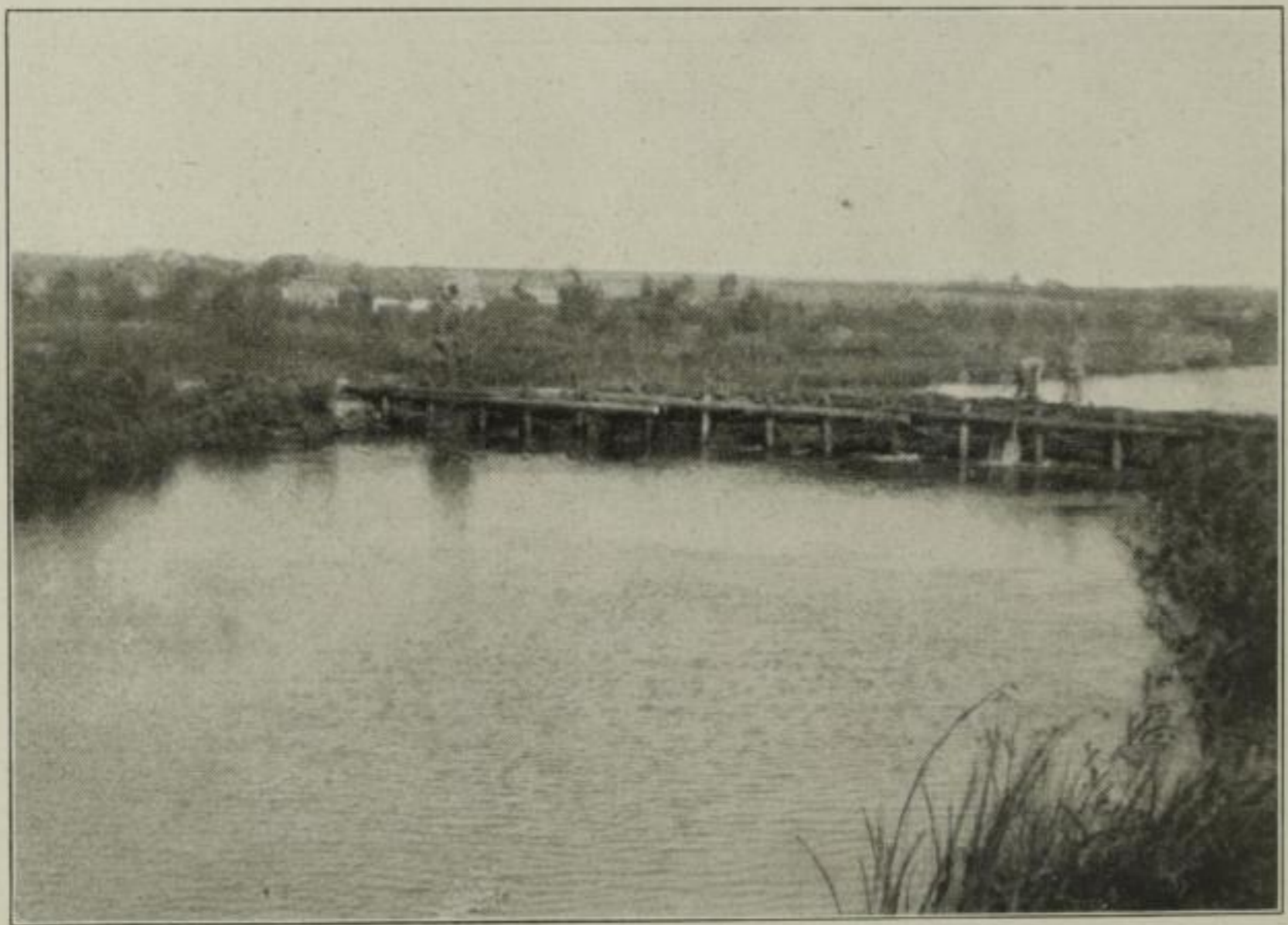
Staugebiet bei Auglicourt
