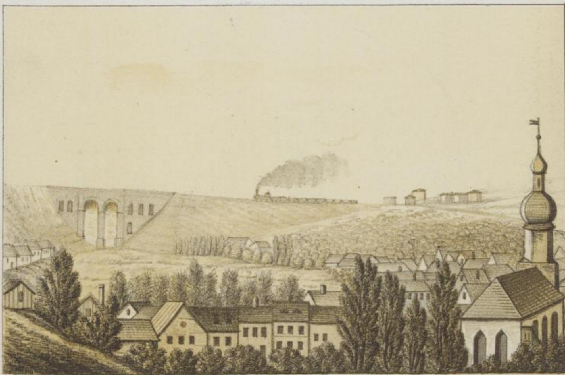
VIADUCT BEI APOLDA.
