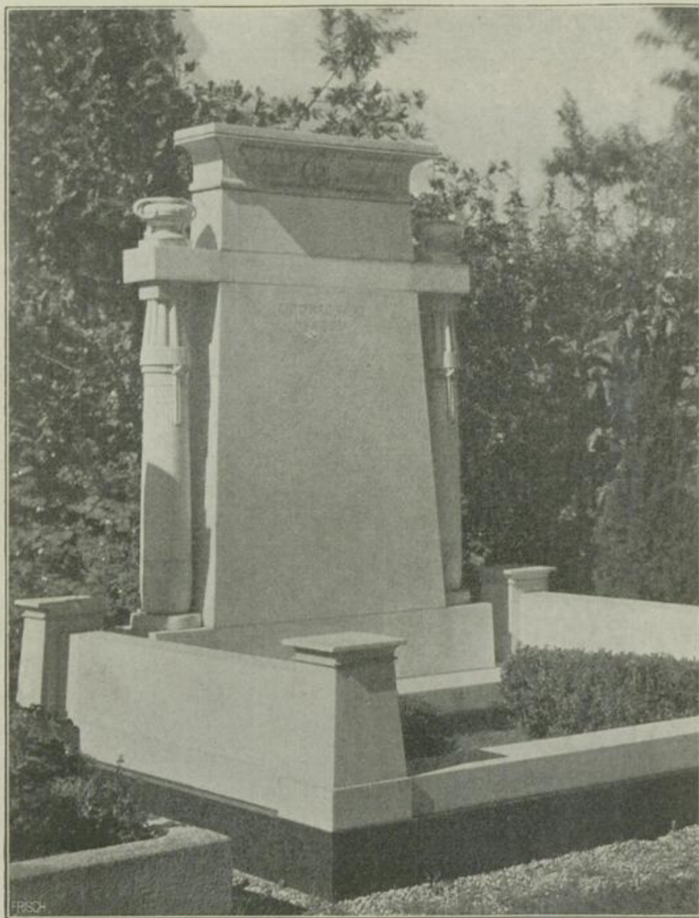
Abb. 15. Grabdenkmal von Architekt R. Wurz, Stuttgart (vergl. S. 28).
