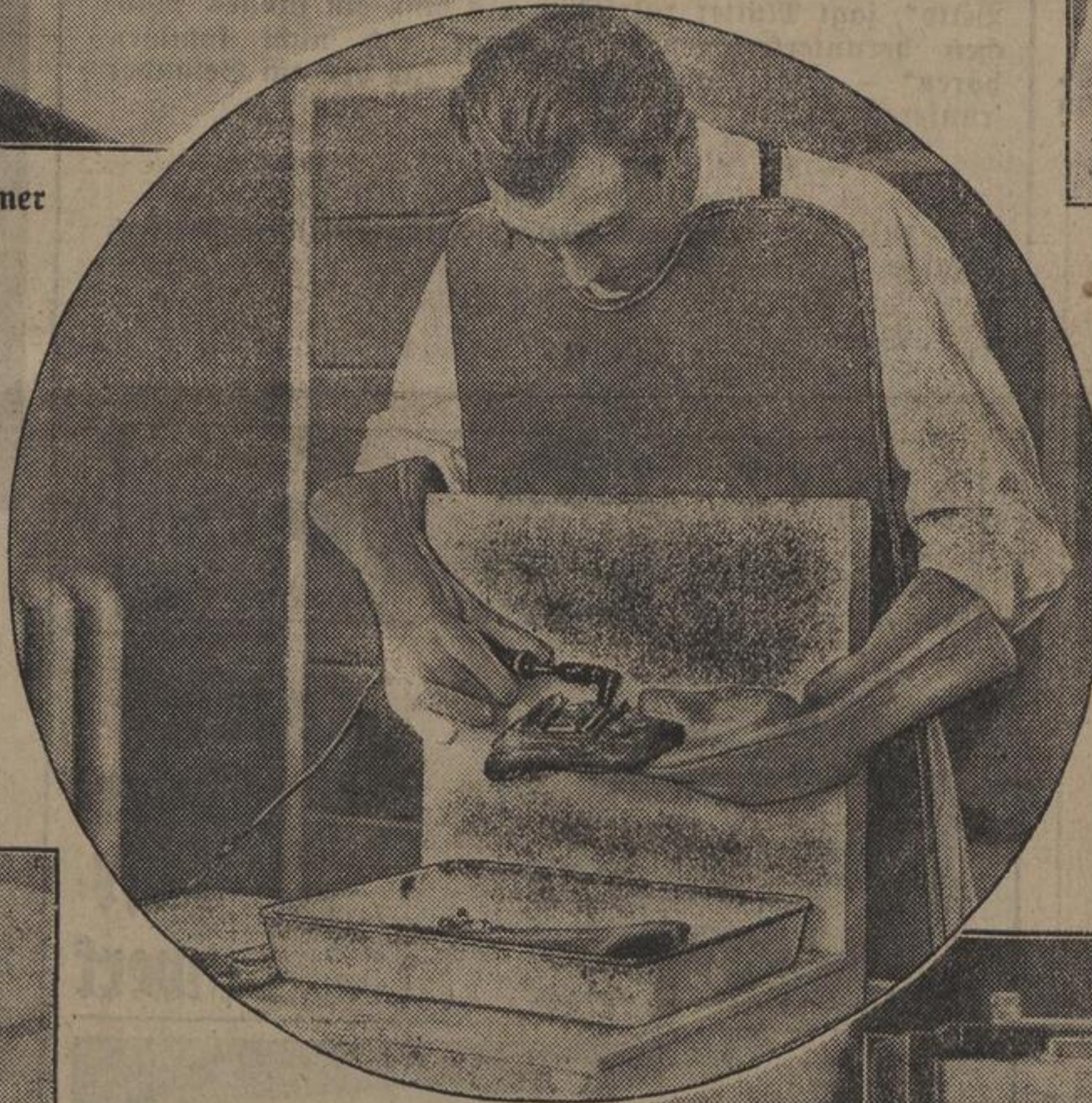
In einem Abdruck aus Kautschuk und Wachs wird das Radium-Röhrchen eingeschmolzen.
