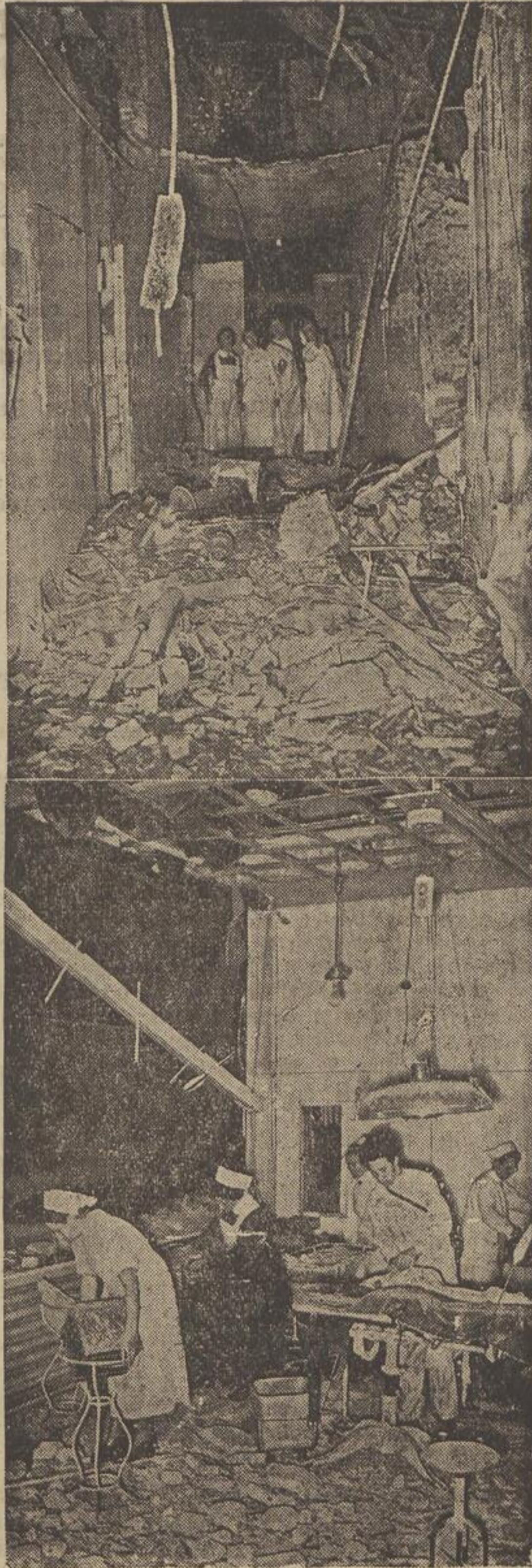
Blick in den durch feige britische Nachtpiraten zerstörten Operationsaal des weltbekannten Robert-Koch-Krankenhauses. (Arbeitsbild (M)).
