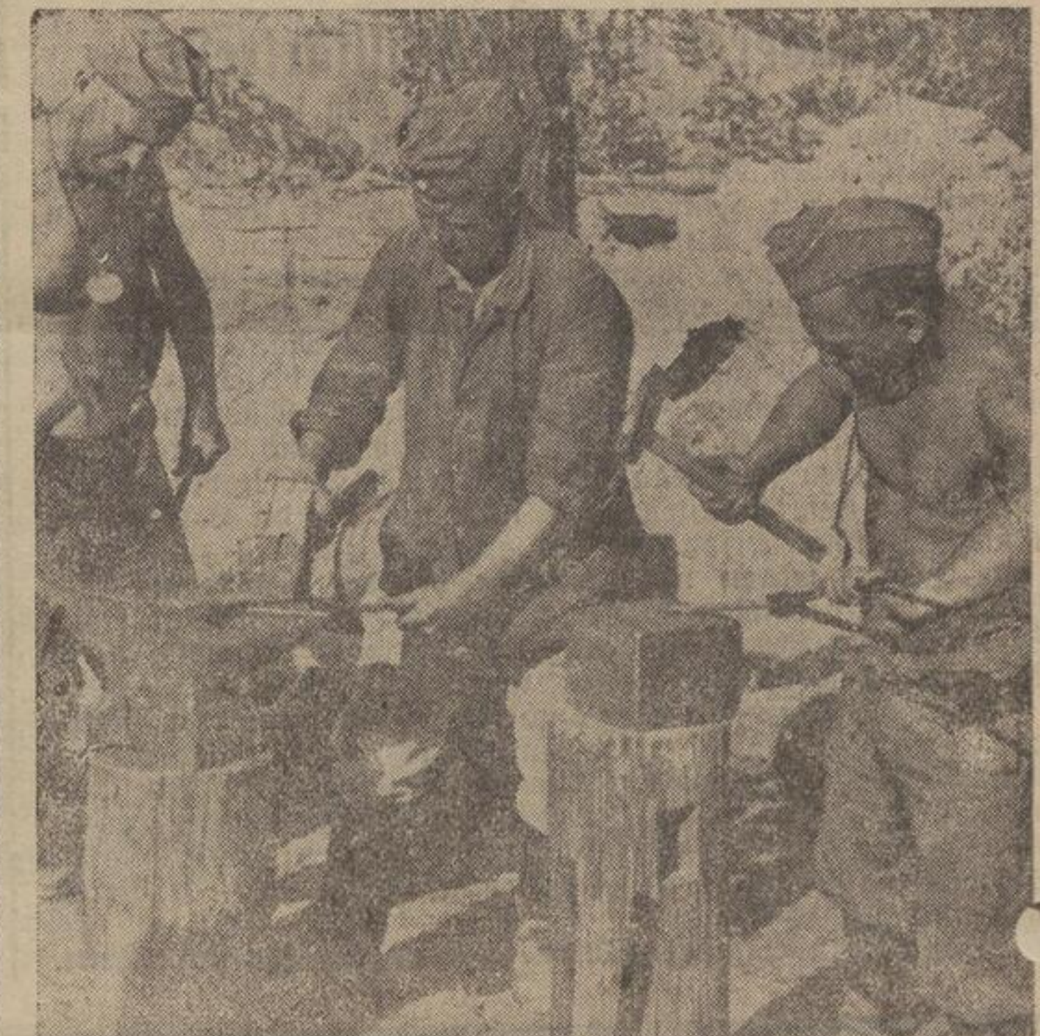
Bei der Arbeit an der Feldschmiede. Schmiedearbeiten der Brückenbau-Kompanie eines Pionierbataillons, die einen behelfsmäßigen Uebergang zu errichten hat. P.R. Engelhardt-Weltbild (M)
