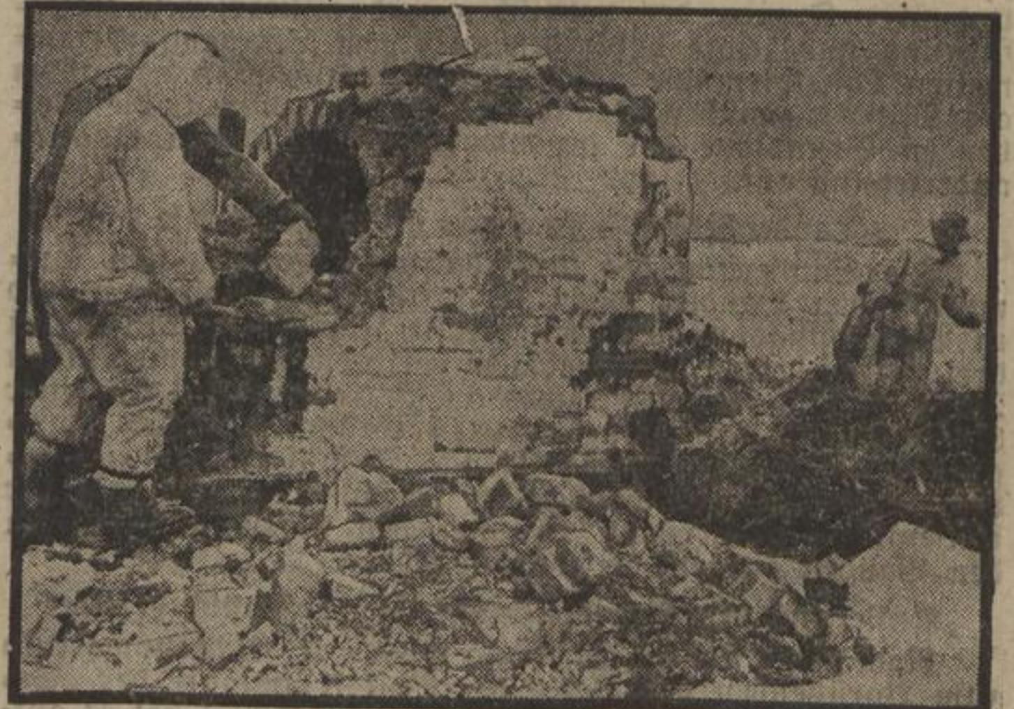
Ein Bunker entsteht
