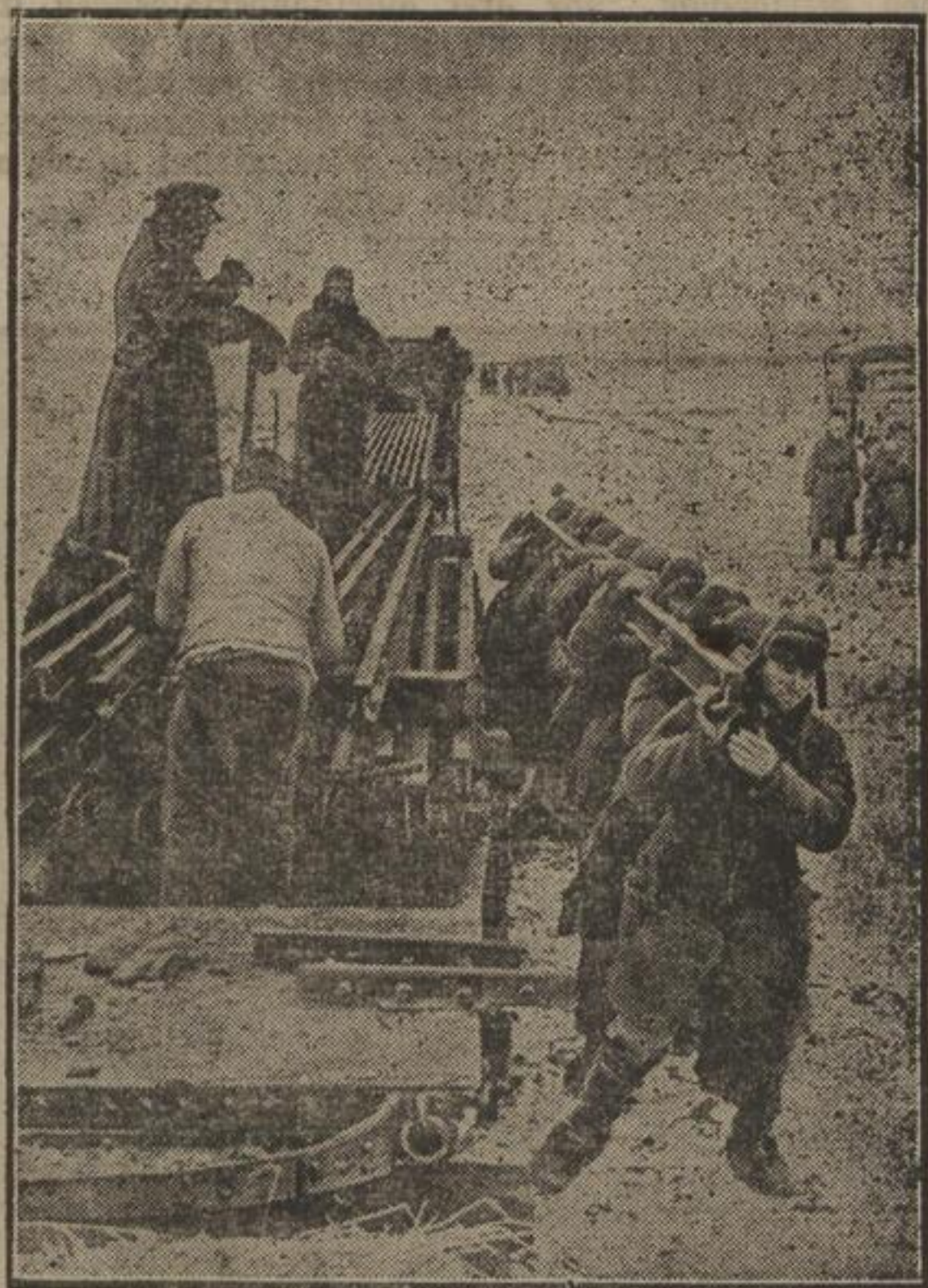
Ein neuer Schienenweg wird gelegt
