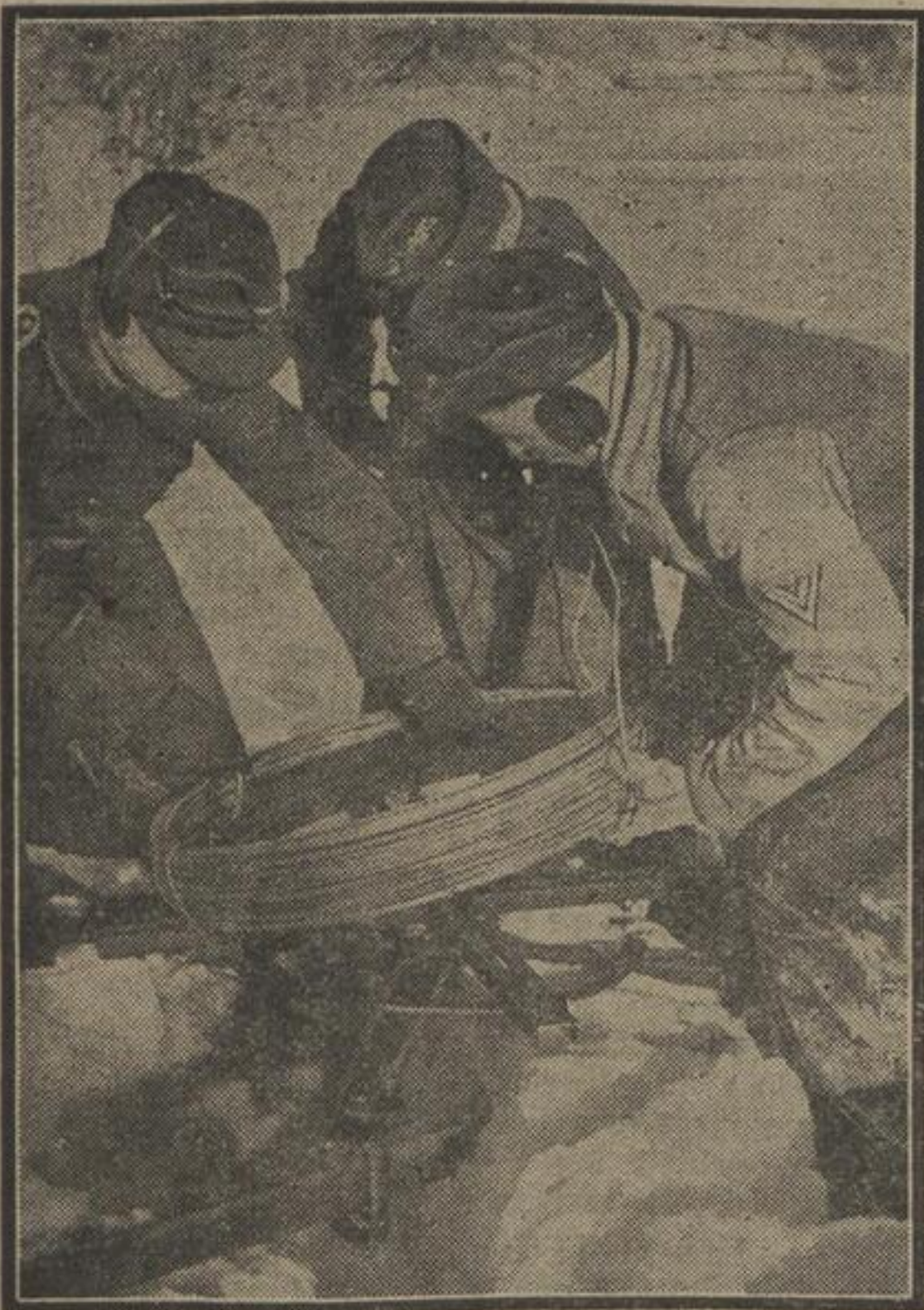
Eine Fernsprecheitung wird verlegt
