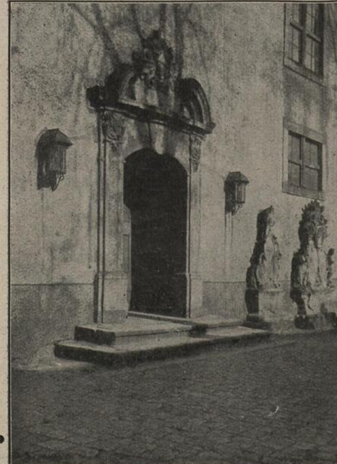
Das westliche Kirchportal
