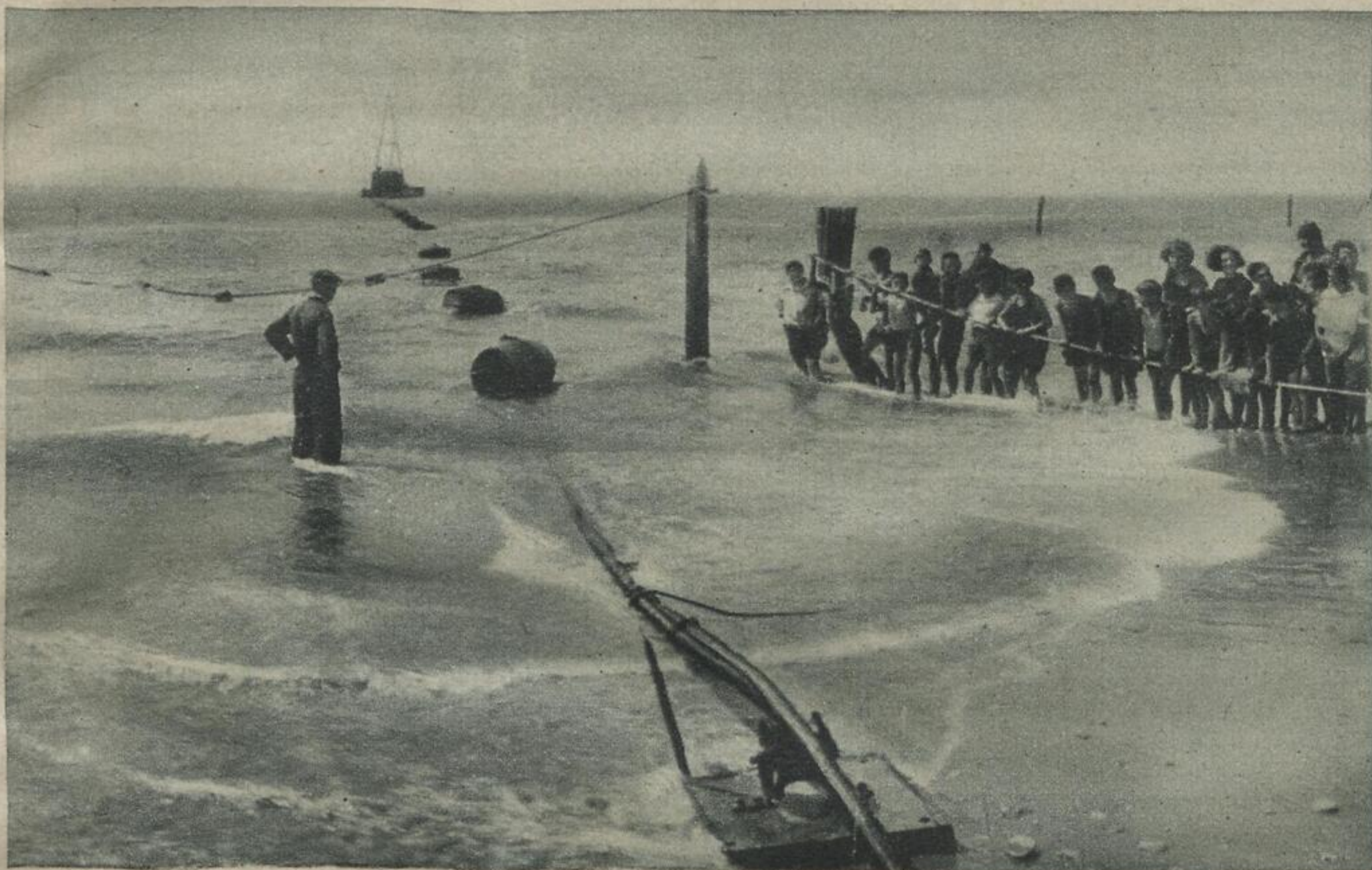
Ein neues Kabel von bisher unerreichter Leistungsfähigkeit wurde zwischen England und den Vereinigten Staaten gelegt und endet in der Nähe von New York. Es hat eine Länge von 6000 Kilometern und ermöglicht es, 2500 Schriftzeichen in der Minute zu senden. Das ist eine achtmal größere Leistung, als alle früheren derartigen Anlagen gestatteten Phot. Scherl
