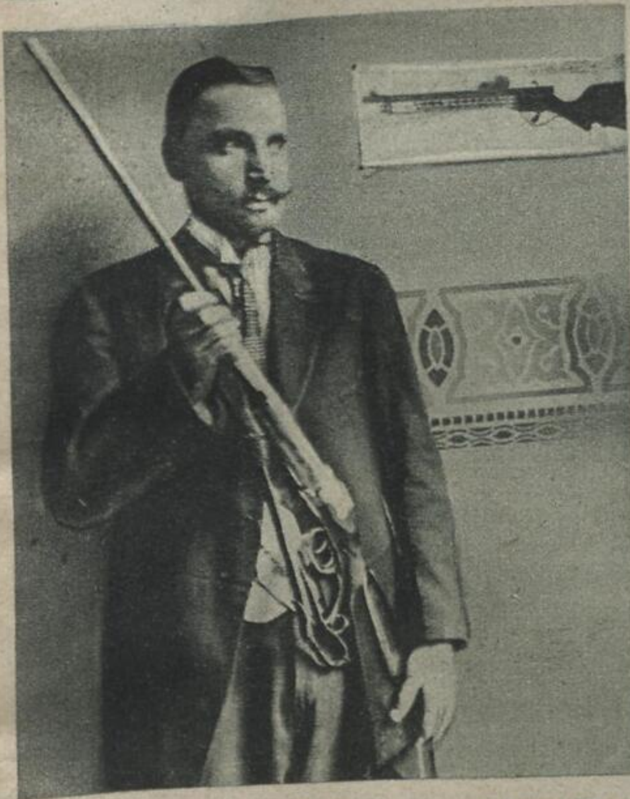
Eine umwälzende Erfindung auf dem Gebiete der Waffentechnik soll dem Berliner Plieth gelungen sein. Er erbaute ein Gewehr, dessen Patronen mittels Preßluft geräuschlos, dabei aber mit außerordentlicher Kraft, abgeschossen werden. Jede Ladekammer faßt 25 Schuß und ist in 1 1/2 Sek. auswechselbar Phot. Preß-Archiv
