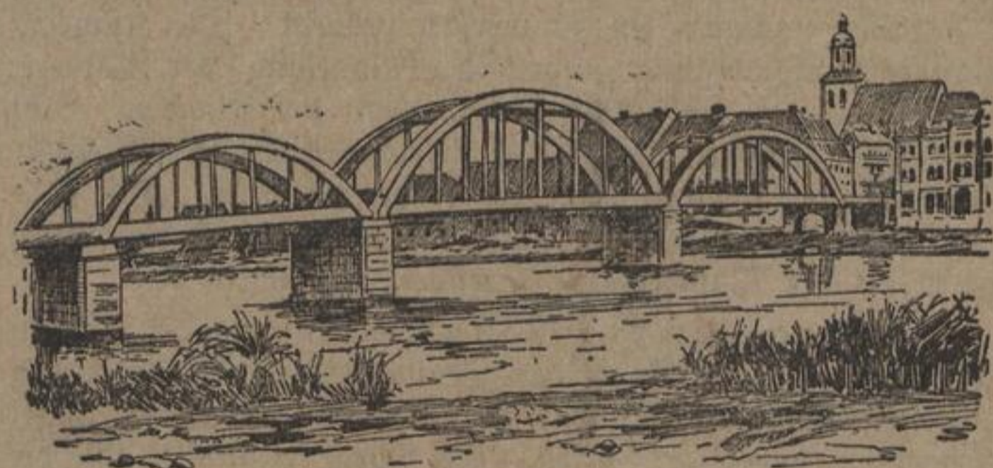
Die Oberbrücke bei Garz, die am vergangenen Sonntag einstürzte.
