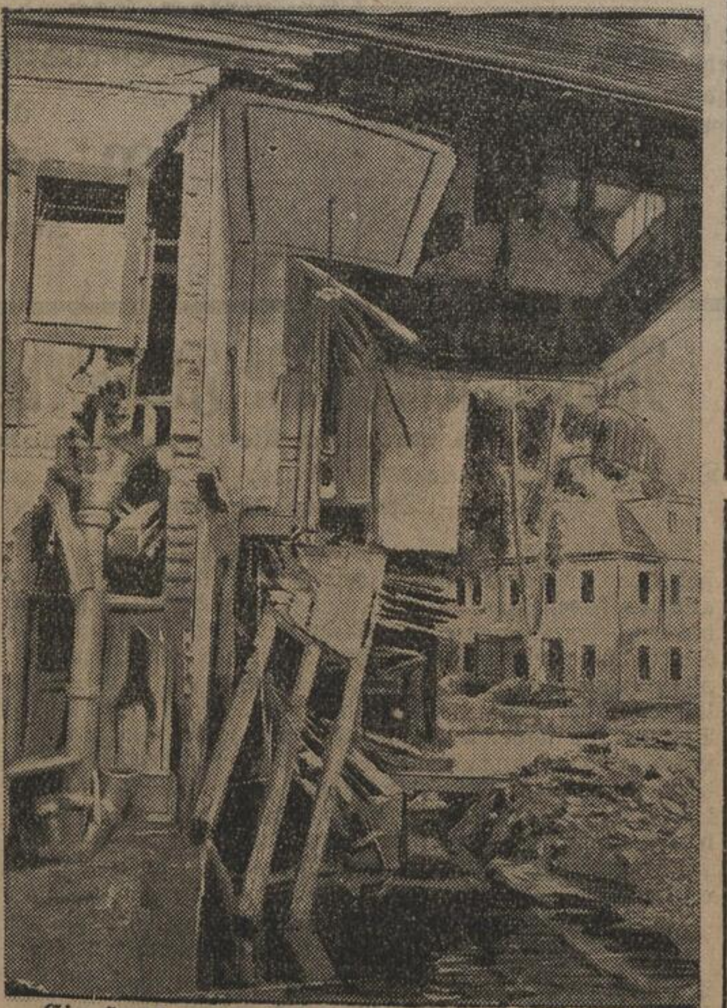
Ein Haus wie das andere ist bis zu den Grundmauern zerstört.
