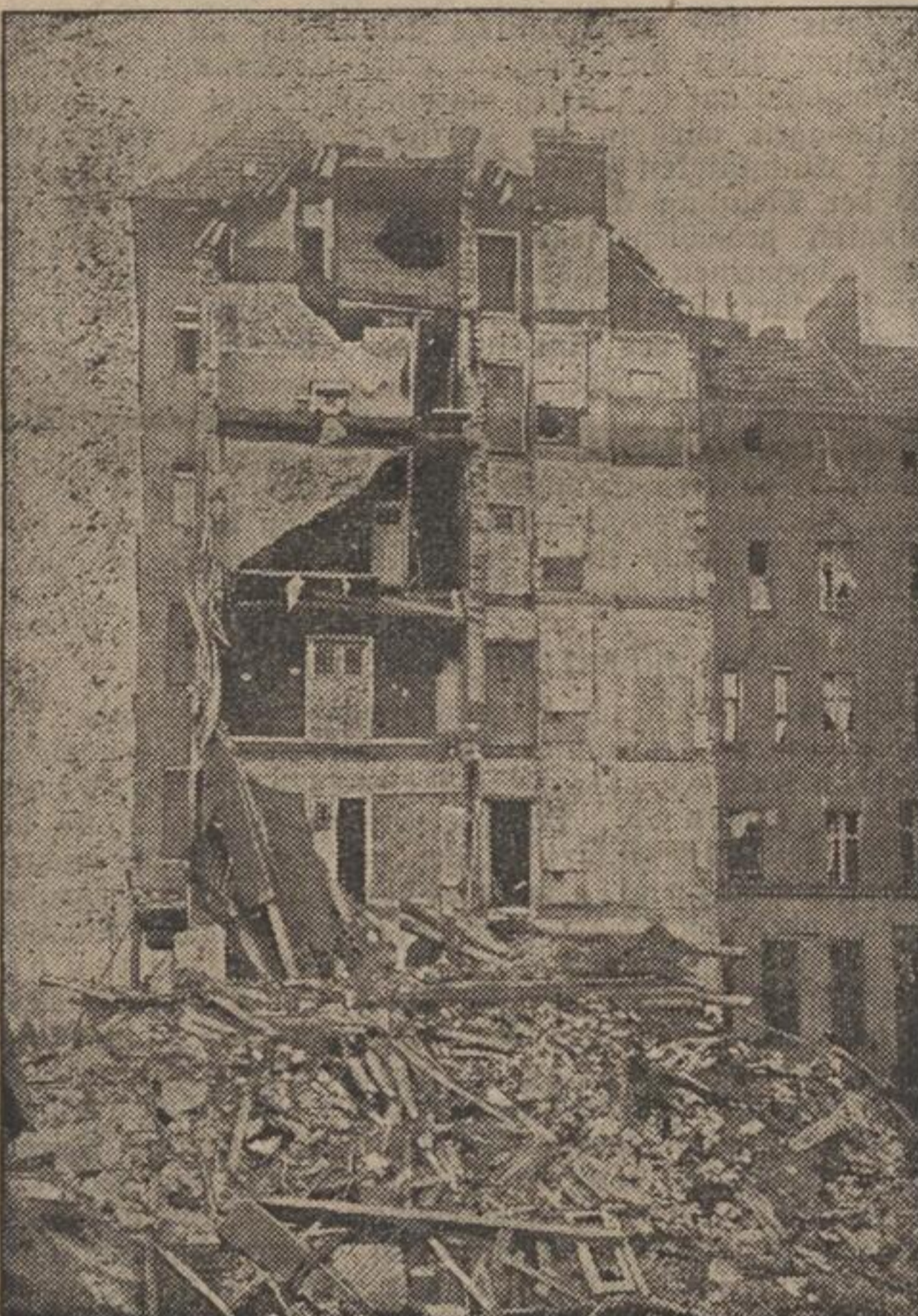
Das zerstörte Haus.
