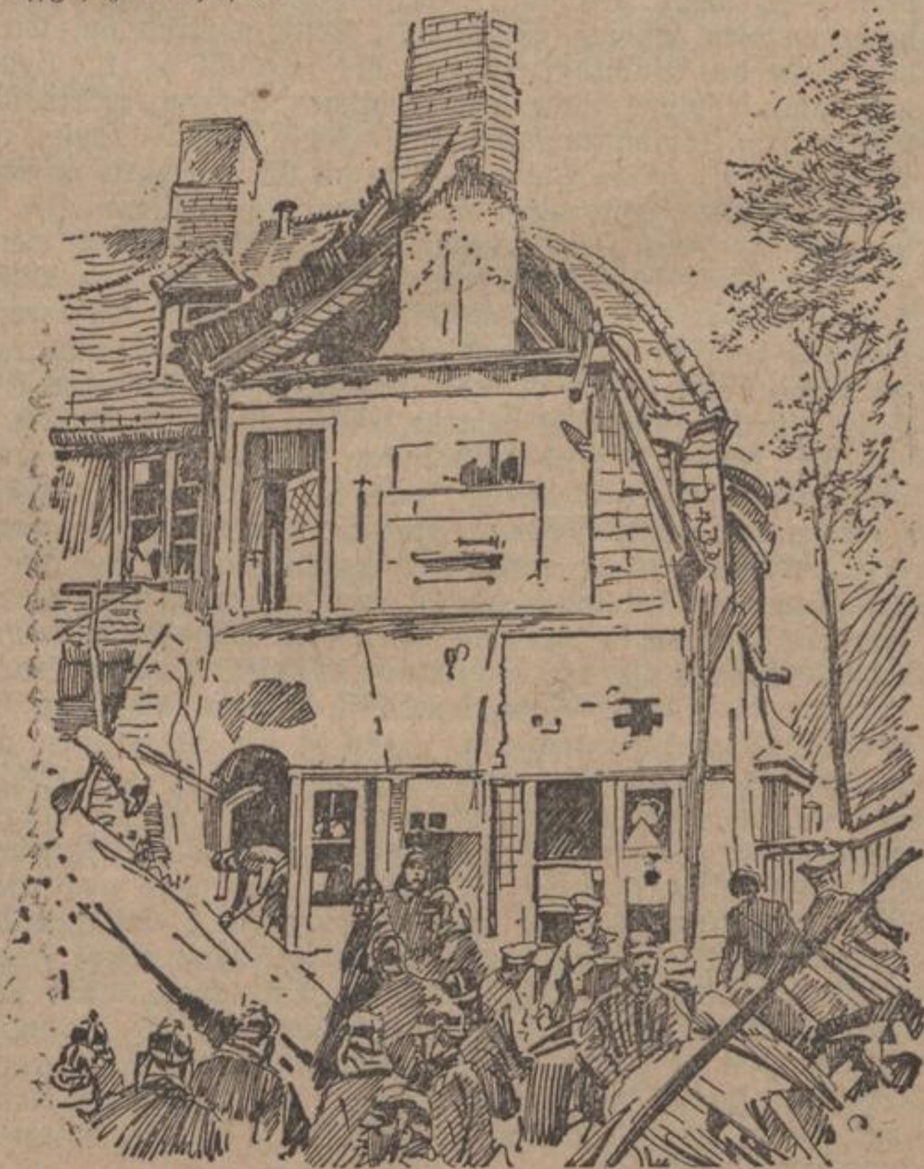
Die durch Explosion zerstörte Villa in Berlin-Dahlem.
