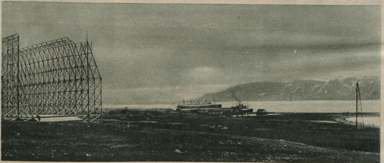
Das nächste Ziel Nobiles: die Königsbucht (Kingsbay) auf Spitzbergen. Links die Luftschiffhalle, rechts der Ankermast für Luftschiffe. Zwischen beiden der Kohlenhafen und der Havag-Dampfer „Resolute“. Die Halle ist nach oben hin offen. Die Seiten werden vor der Benutzung bespannt. Der Luftschiffhafen wurde für die „Norge“ errichtet, mit der Amundsen 1926 erstmalig den Nordpol überflog. **Früh v. Lindenau**
