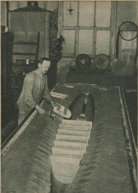
Modellieren einer Schiffform in Ton mit Hilfe hölzerner Schablonen, die vor dem in Paraffin ausgeführten Guss des Schiffkörpers entfernt werden
