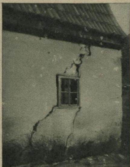
**In Schwürbitz bei Richtenfels, Oberfranken,** machte sich ein Bergsturz bemerkbar, der die Mauern einiger Häuser zerriß, die Balken und Fußböden spaltete und Verschiebungen bis zu 40 Zentimetern hervorrief. Für die Häuser besteht Einsturzgefahr. Kummel, Bamberg
