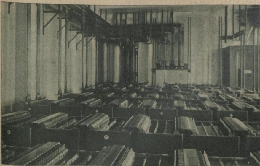
Ein Sammlerraum in einem der neuen Fernsprechkämer der Großstadt, das mit mechanischer Verbindungsherstellung auf Grund automatischer Wähleranlagen bei jedem Teilnehmer arbeitet. Das
