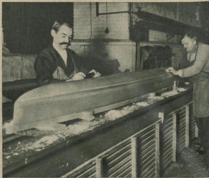
Bei der Bearbeitung des gefrästen Schiffmodells
