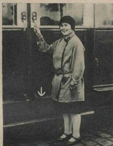
**Kein „Aufspringen“ während der Fahrt“ mehr!** Verschiedene Straßenbahngesellschaften sind dazu übergegangen, ihre Wagen mit einer Vorrichtung zu versehen, die das Aufspringen auf die Trittbretter der Wagen während der Fahrt unmöglich macht. Diese Vorrichtung (↓) arbeitet gleichzeitig mit dem Öffnen und Schließen der Türen S.B.D.
