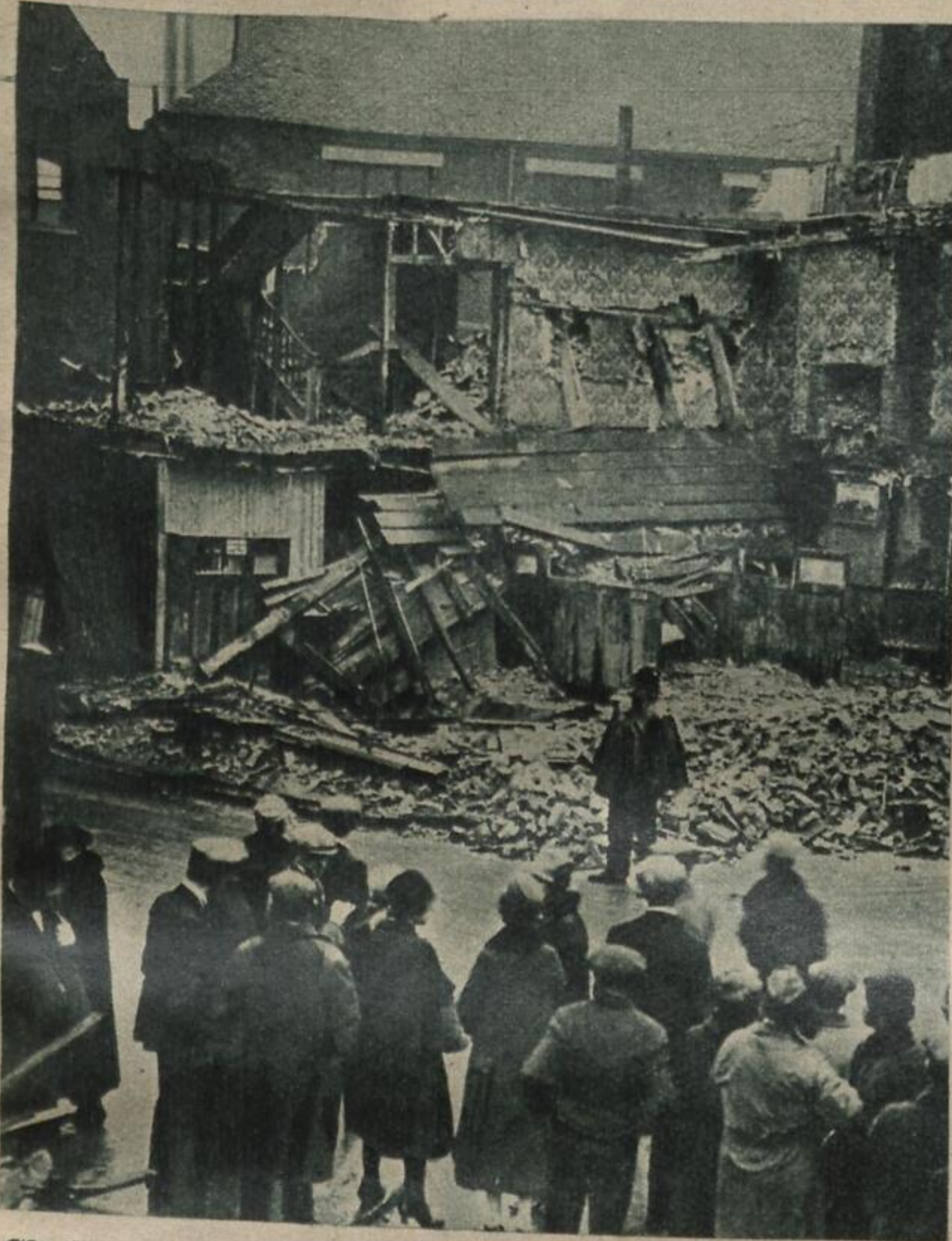
Auch in London stürzte ein Haus ein. Man nimmt an, daß das Grundwasser die Fundamente beschädigt hat. Auch hier sind einige Tote und mehrere Schwerverletzte zu beklagen Sennecke
